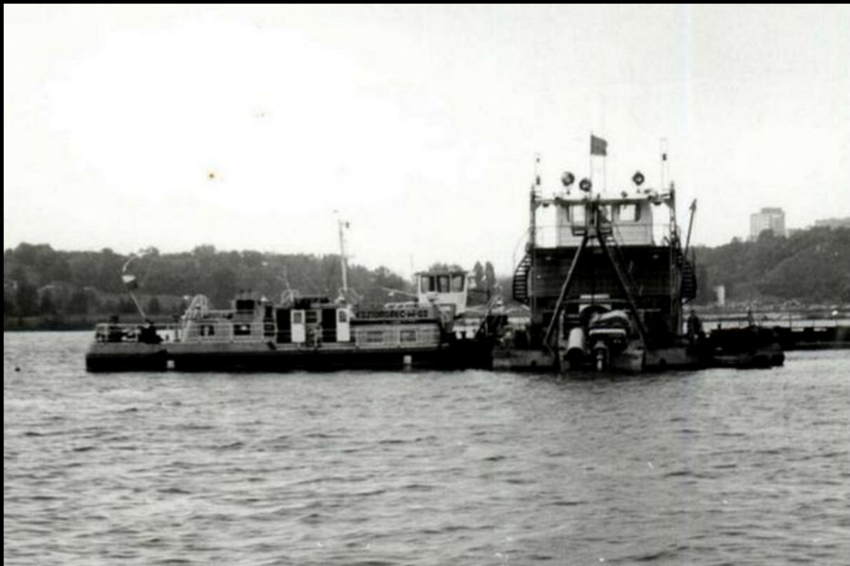
Pchacz "Koziorożec W-02" obsługuje pogłębiarkę "Wisła,, Płock, 1982r.
