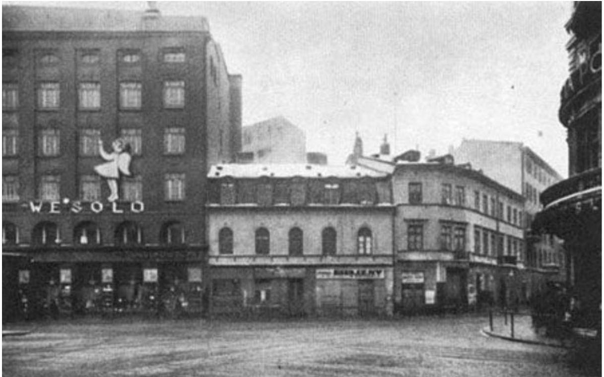
Rysunek 11 Dom Towarowy Bracia Jabłkowscy, kamieniczka Bracka 27, narożna Chmielna 19, dalej widoczna kamienica Chmielna 21. Źródło: warszawa1939.pl
